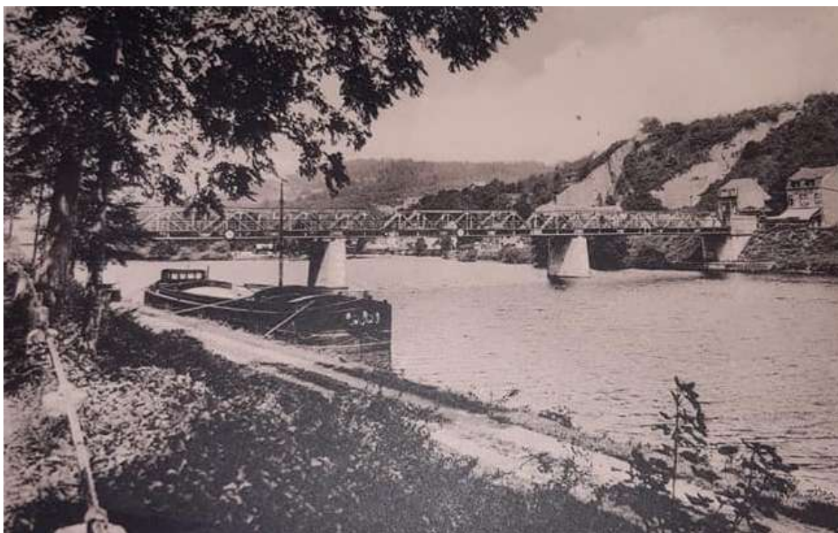
Figure 23. Trois travées de structure identique avec celle du milieu sur un léger porte-à-faux des deux autres.
