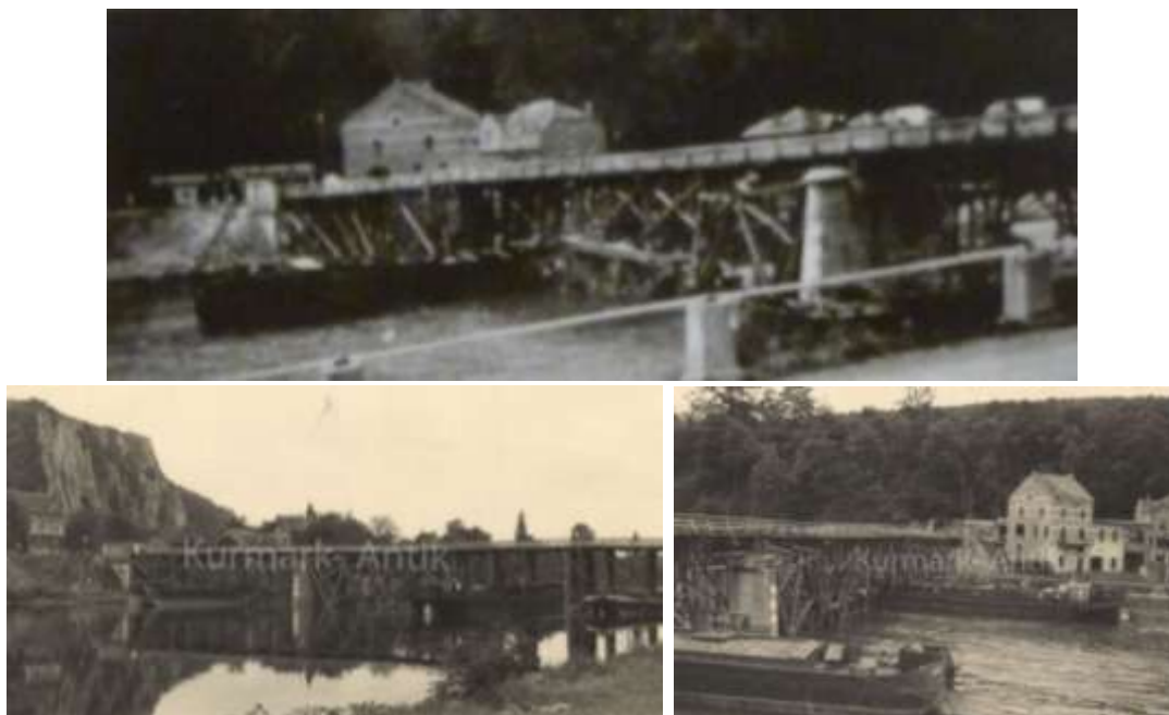
Figure 14. Construit en bois, il sera emporté par les eaux en novembre (peut-être en entraînant le soldat allemand, pionier, Karl KÖTZING, né le 5 janvier 1909 et qui s'est noyé dans la Meuse à Yvoir la nuit du 5 au 6 novembre 1940 ?). Toutefois, le passage des civils se faisait essentiellement en barque, conduite par Joseph François. © Musée du Souvenir de Haut-le-Wastia (1), eBay.de (2-3).
