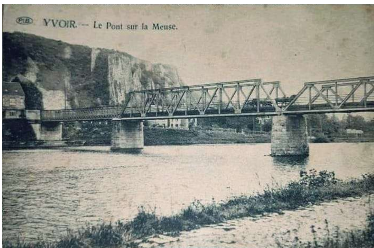
Figure 7. Pour datation : un attelage hippomobile... et la travée vers Yvoir est celle d'avant la guerre de 1914. Chaque travée s'arrête au milieu des piles, contrairement à la version ultérieure.
