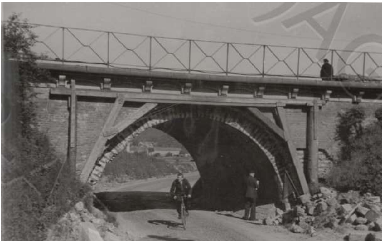
Figure 49. Reconstruction de la partie au dessus du fleuve mais aussi au-dessus de la route. Celle-ci changera du tout au tout quand on élargira la route du temps où, comme au nouveau pont d'Yvoir, on voulait que les voitures puissent aller vite...
