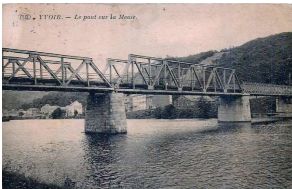
Figure 8. Vu des rochers et vue des rochers. (On remarquera que les poutrelles étaient plus massives que celles de 1942... comme on le verra.) Vue du côté amont.
