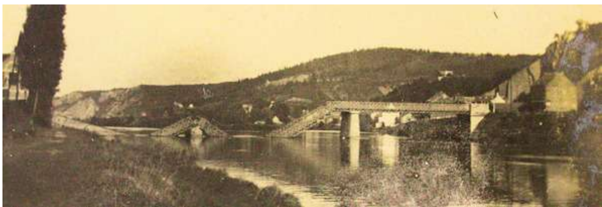
Figure 5. Miné par le génie belge de concert avec le génie français, avec de la mélinite par les Belges et de la tonite en cartouche de 100 grammes par les Français, le pont d'Yvoir est détruit à 16h45, mais, imparfaitement réussi, le génie recommence le minage de l'ouvrage. Une seconde explosion achèvera le travail. Seule la travée vers Yvoir subsiste...
