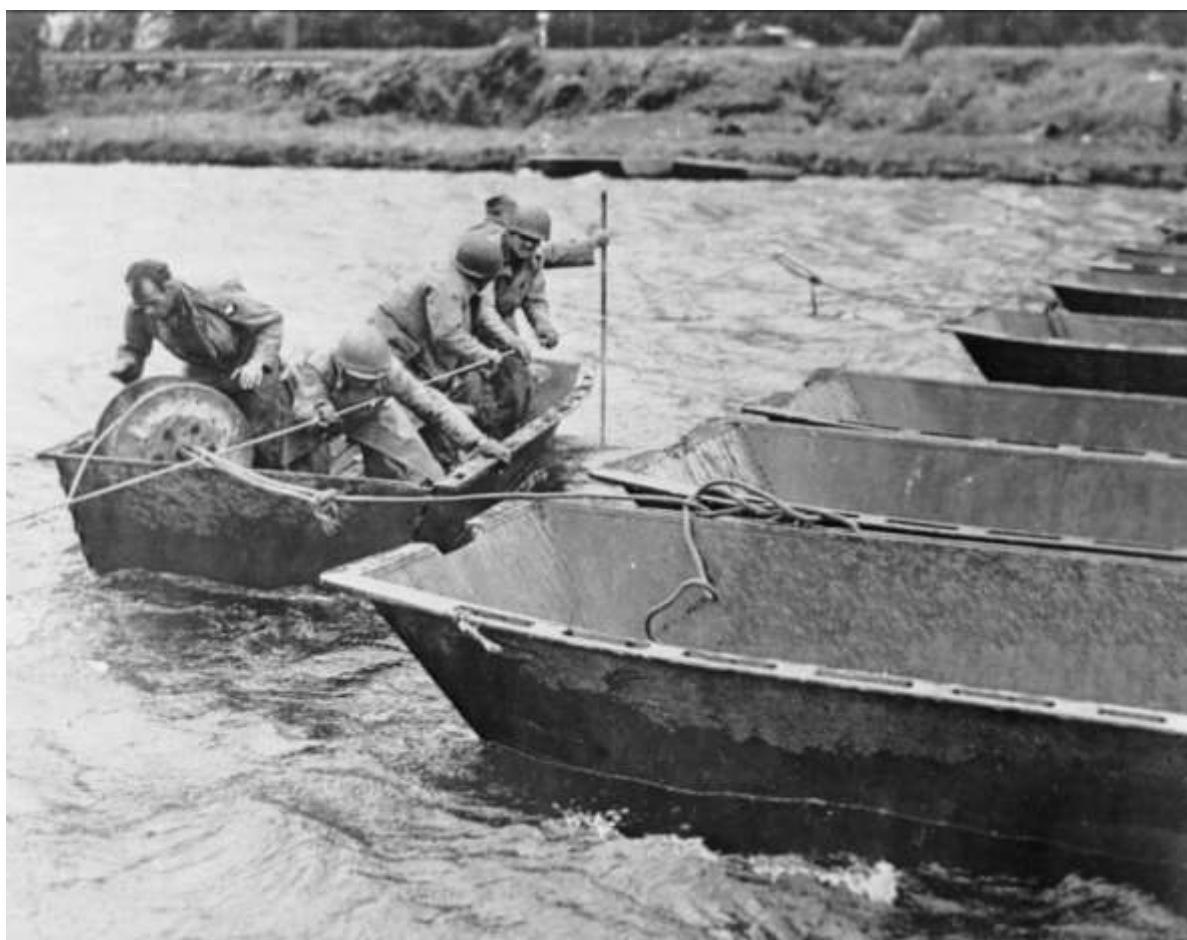
Figure 48. A Houx, des éléments du génie de la 1 ère US Army établissent un pont de bateaux sur la Meuse. © imago-images.de
