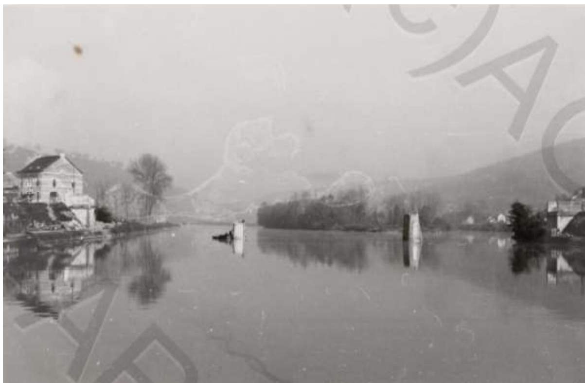
Figure 17. Les piles du pont démoli. © Archives Générales du Royaume – Ministère des Travaux Publics.
