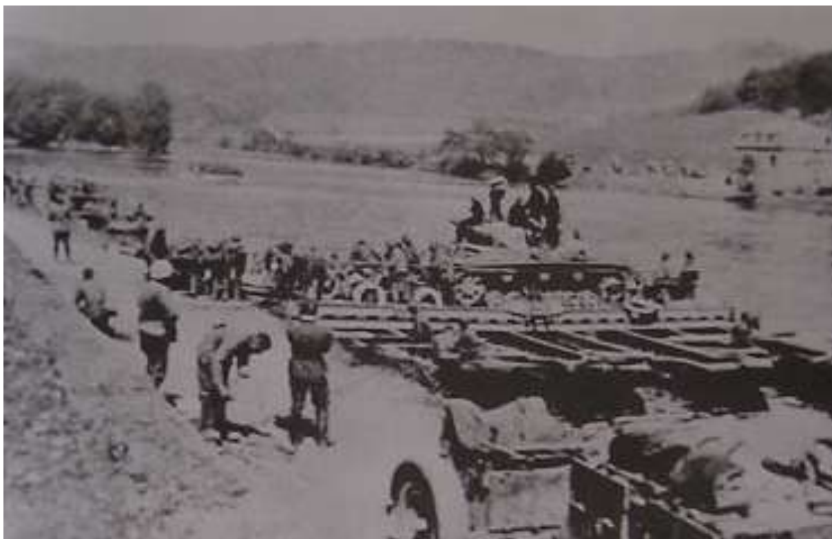
Figure 38. Pour faire traverser la Meuse aux blindés lourds, les Allemands disposaient déjà d'un matériel de génie très sophistiqué qui pouvait être monté en fort peu de temps. Ils assemblèrent entre Houx et Leffe (entre l'île de Houx et l'île d'Al Golette) dix-huit portières sur lesquelles leurs chars traverseront la Meuse. Ici, une de ces portières accostant sur la rive gauche de la Meuse à la hauteur du Mont Noir, en face de l'Auberge de Bouvignes. En arrière-plan, on distingue l'écluse de Houx. © DETLEV von PLATO - Dinant 1940/1945 de Jacques Olivier et Eddy Piot
