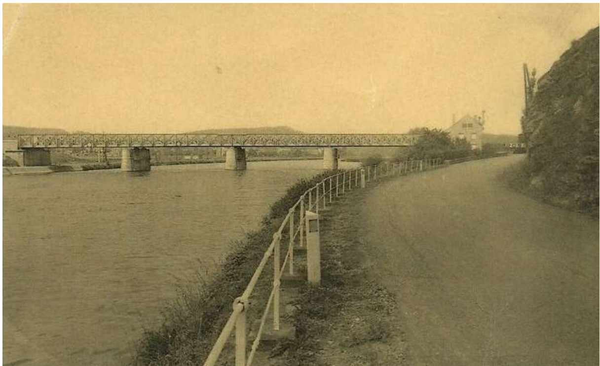
Figure 33. Pont chaque fois en poutres en croix de Saint-André (juxtaposition des systèmes Pratt et Howe). Les panneaux carrés n'ont plus que leurs diagonales. Ces vues ne sont pas datées. La première daterait de l'entre-deux-guerres et la seconde d'après 1945 avec pour caractéristique des poutres devenues moins épaisses, dirait-on. De plus, actuellement (depuis la reconstruction ?), l'autre côté comporte un passage pour piétons. © Delcampe.
