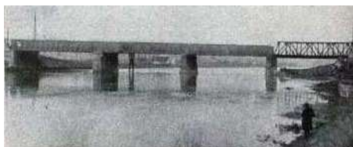
Figure 32. Le pont "réparé". Remarquez la béquille dont est pourvue la deuxième arche et la nouvelle arche à droite... © Traces Mosanes – Au Fil de la Meuse.
