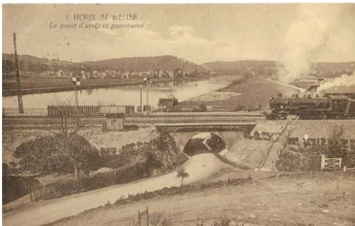
Figure 34. Le prolongement du pont : le passage inférieur de la route Dinant-Namur. © Jean-Pierre Lallemand - Yvoiriennes, Yvoiriens.
